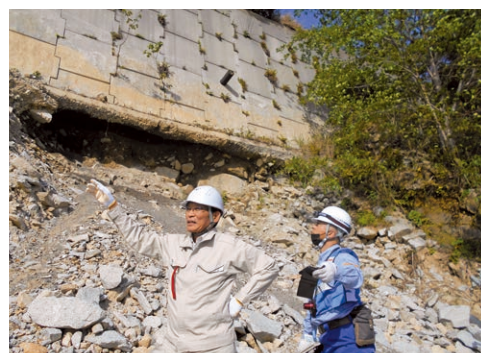
道路防災ドクターとの現地合同点検状況
