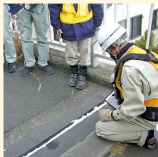
発泡ウレタンフォームによる簡易止水事例
